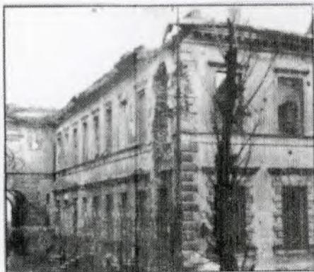
1945r Zniszczony budynek Instytutu od strony placu Trzech Krzyży po kapitulacji Powstania Warszawskiego
